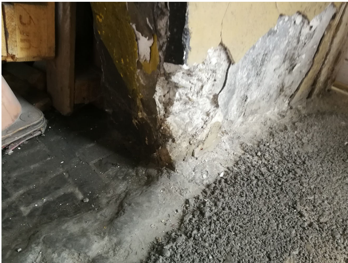
Obr.13 – rozpad betónu v dôsledku vzliňania + nárazov vozidiel
